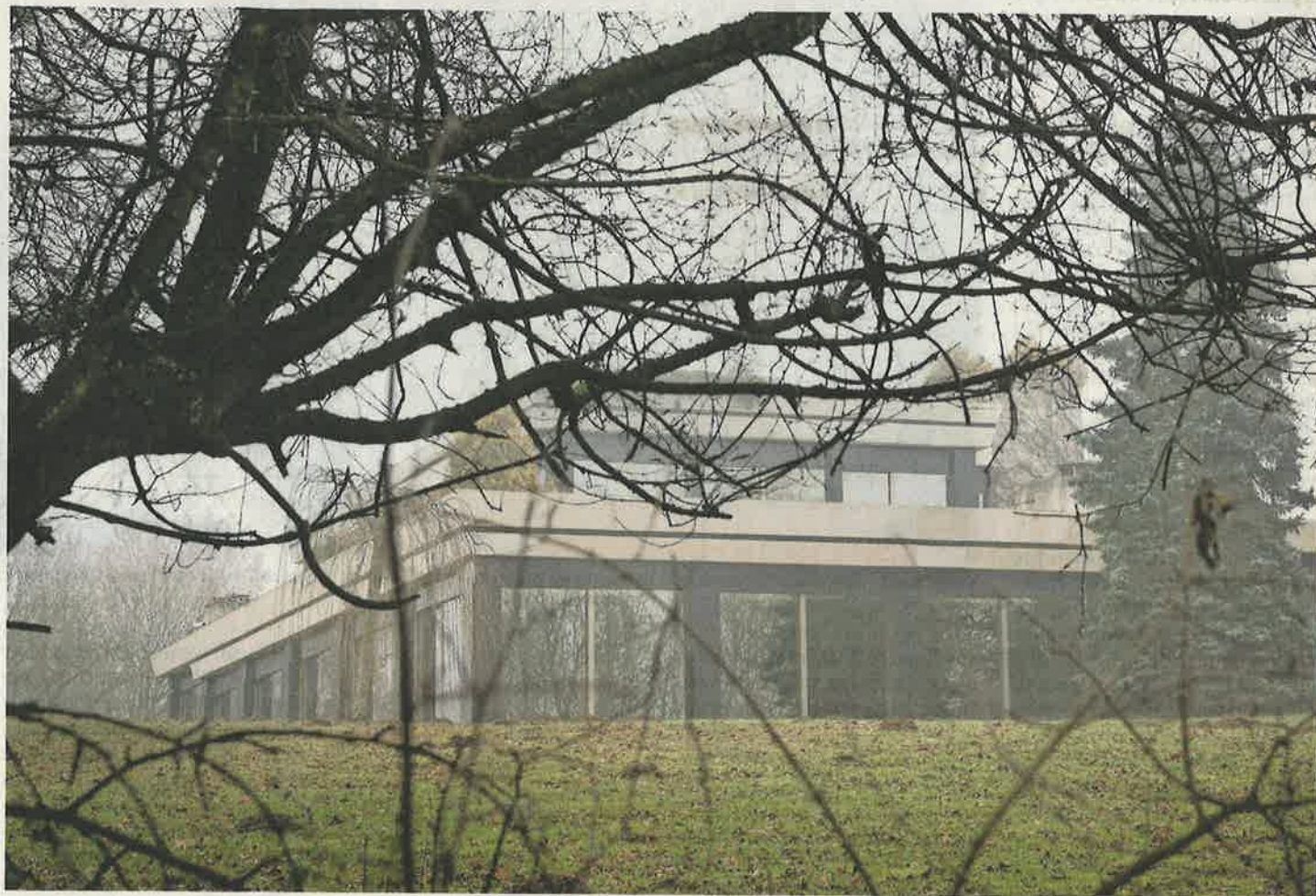
La maison est en grande partie sous terre, ce qui lui vaut le surnom de villa-bunker. Charly Rappo-archives
